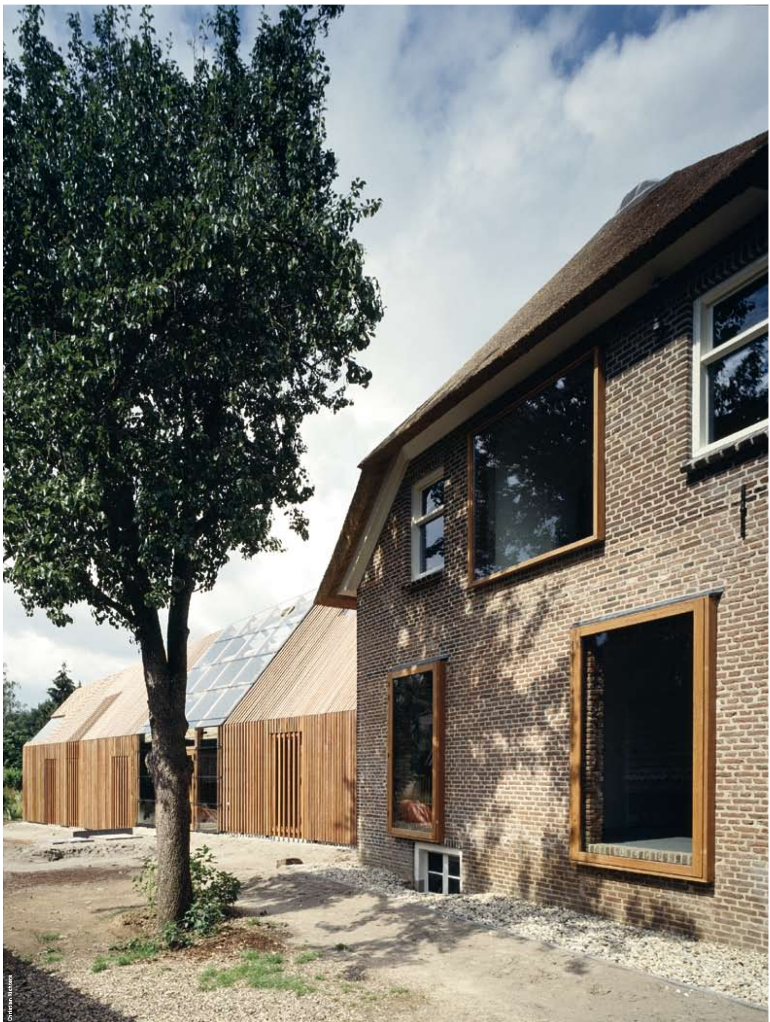
Il corpo principale della vecchia fattoria è stato recuperato per adeguarlo alle nuove esigenze The main building of the old farm has been refurbished to make it comply with the new requirements
