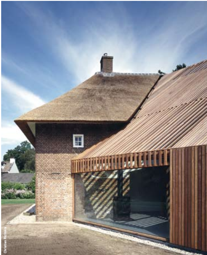
L'accostamento tra i corpi conservati e il nuovo volume è risolto anche grazie alla scelta dei materiali The combination between the refurbished buildings and the new volume has been resolved also with regards to the use of materials
